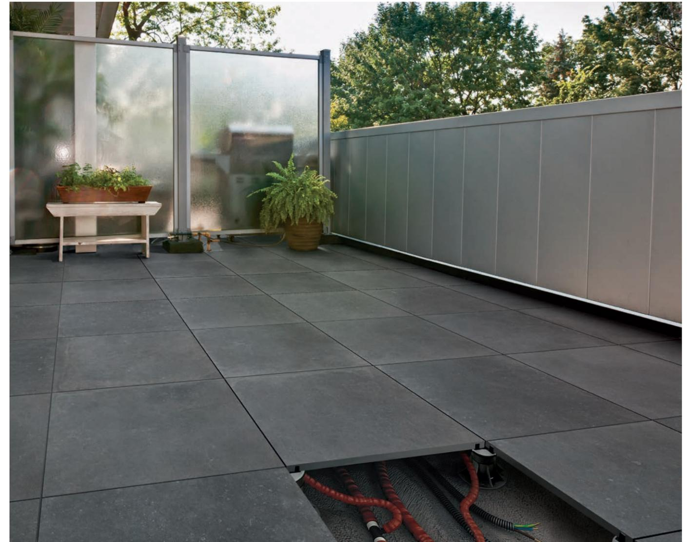
L'assemblaggio a secco della struttura si rivela molto efficace in contesti dove è importante un corretto drenaggio dell'acqua.
